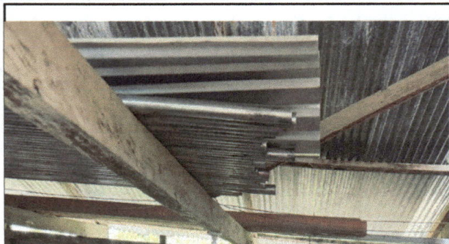
Fotografía 2: Vista de la estructura de techo de madera, se sustituirá por estructura de techo de metal.
